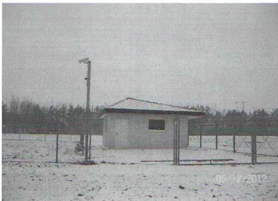
Рис.1. Домик для хранения инвентаря на территории полигона для испытания ГМО (вид сбоку)
