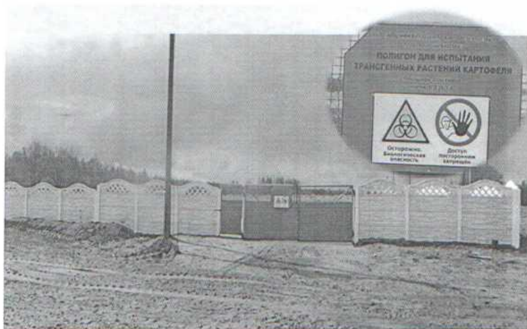
Рисунок А 3 – Фронтальный вид опытного участка: бетонный забор, ворота информационная доска
